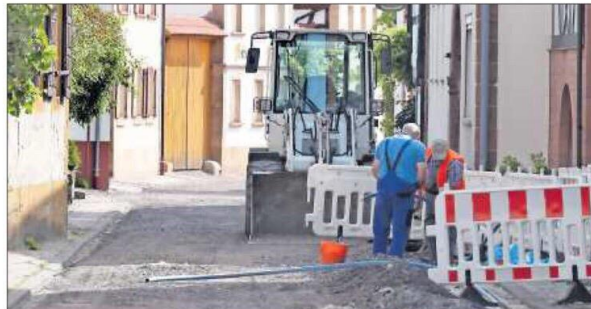
Bis Ende 2016 soll der Glasfaserausbau in Oberhofen beendet sein.
